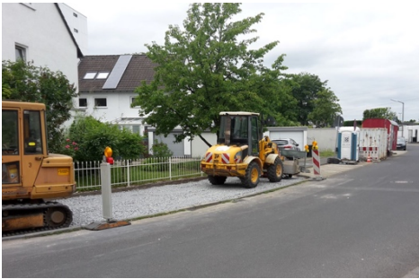
Baumaßnahme Gehweg Montessoristraße
