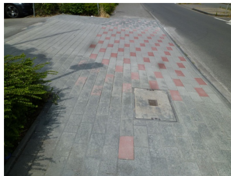
Ausfahrt vom Lidl-Markt nach der Instandsetzung
