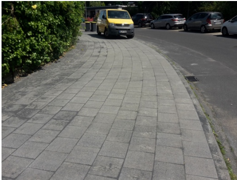
Ergebnis der Baumaßnahme
