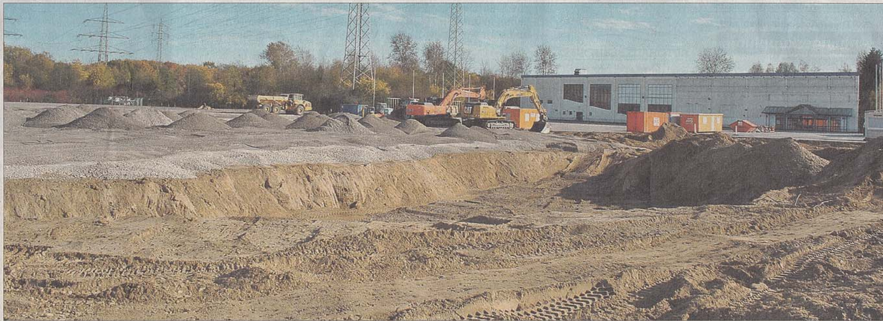
Die Arbeiten auf dem ehemaligen Fegro-Gelände haben bereits begonnen. (Foto: Bläsen)
