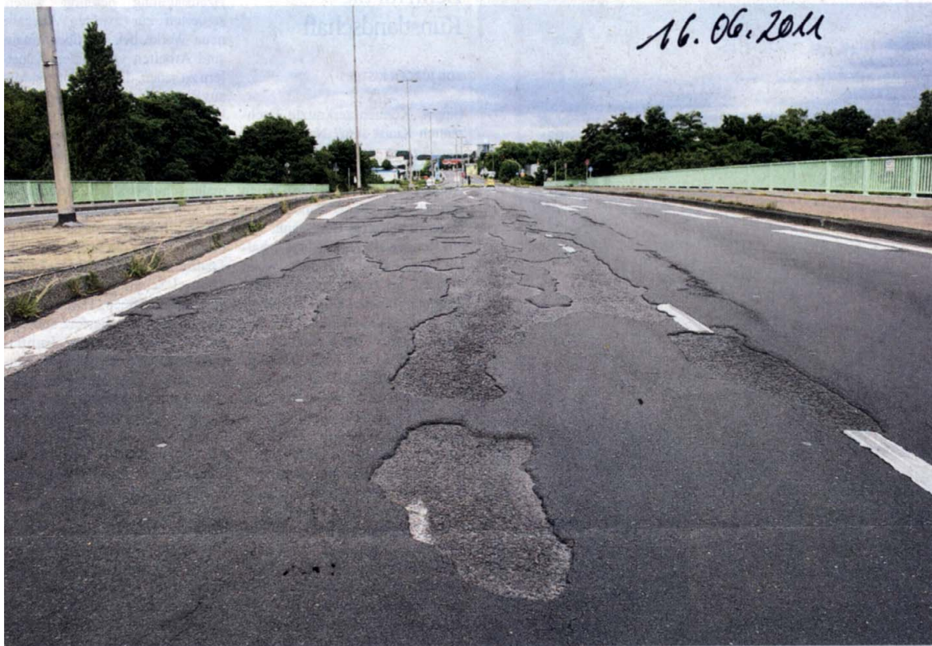
Für 900 000 Euro soll die Fahrbahn der Merianstraße zwischen Freizeitbad und Robert-Bosch-Straße erneuert werden.
